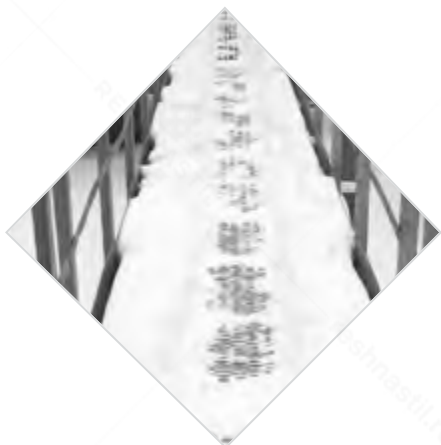
Рис. 1. Состояние ходового мостика из просечно-вытяжного листа
